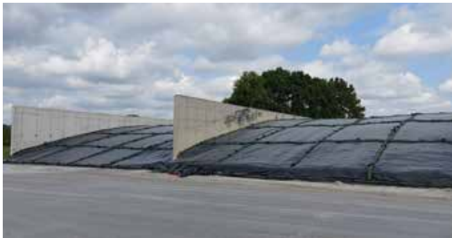
A kavicszsákkal cellásan fixálható a kétrétegű fólia – a vákuumfólia miatt nincs szükség teljes felületű terhelésre (fotó: Orosz, 2023)
