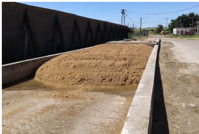
Betonozott ároksiló sörtörköly ideiglenes (7-10 nap) tárolására. A lejtőszög miatt önmagát tömöríti a törköly, kiváló megoldás (Galgamenti Mg. Kft., Tura).
