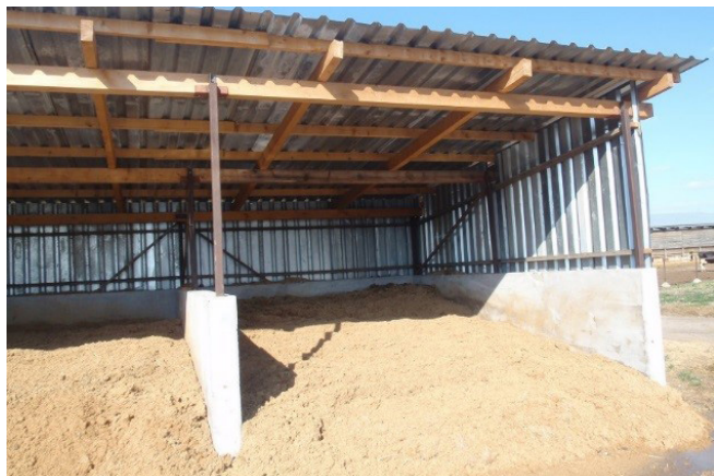
Fedett helyen, fal közé betárolva (kisebb felületi romlás). Az elgondolás jó, a méretezés még nem ideális (fotó: Orosz).
